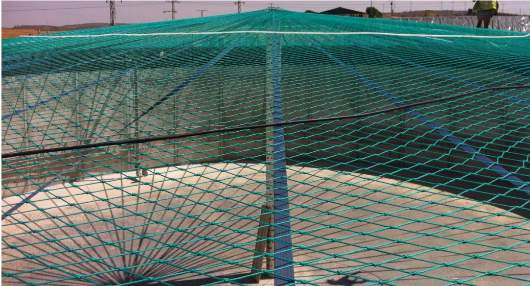
Imagen 16. Estructura de soporte del gasómetro
