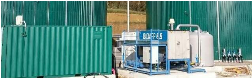
Imagen 9. Equipos de higienización en planta de biogás en Galicia
