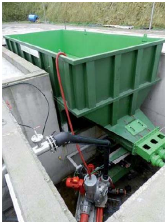
Imagen 14. Cargador de sólidos enterrado
