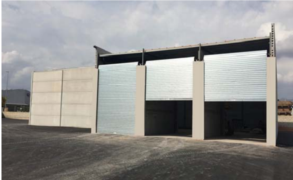
Imagen 11. Nave de recepción de sustratos
