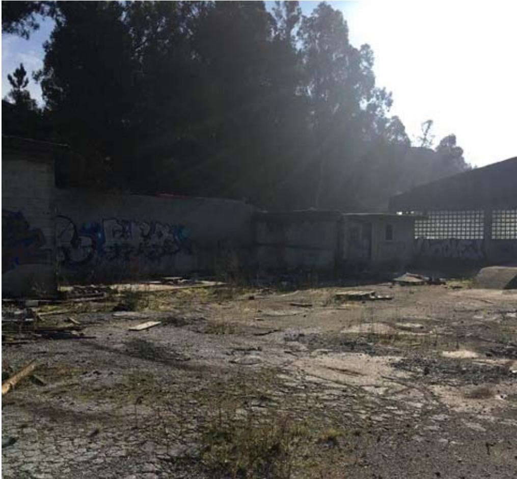
Imagen 24. Zona donde se ubicará la recepción de sustratos, donde en la actualidad se encuentran las ruinas de antiguas edificaciones de la cantera
