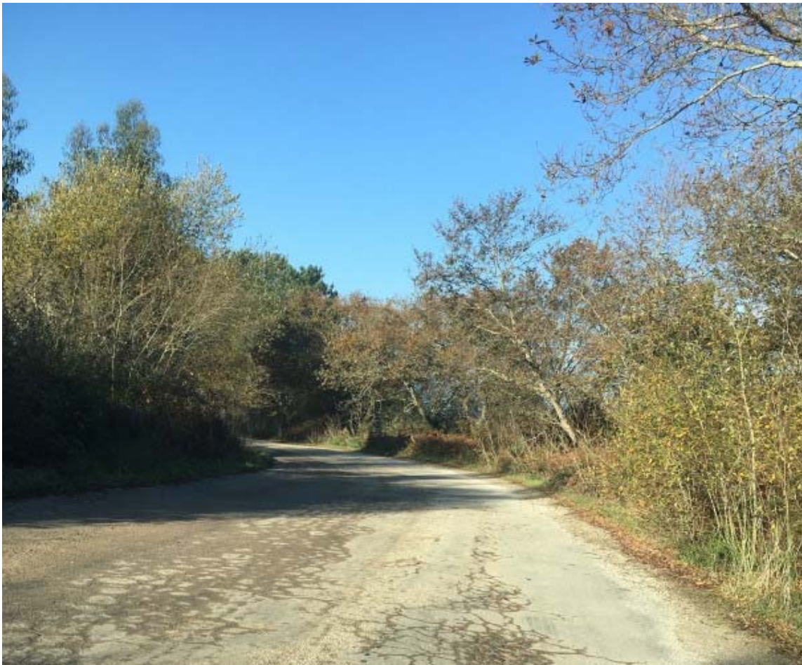
Imagen 21. Detalles del camino principal de acceso a la parcela, ya acondicionado para el tráfico pesado
