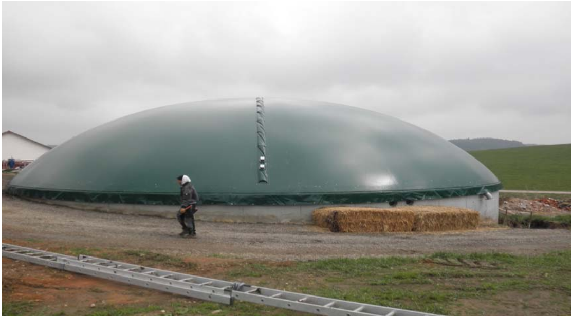
Imagen 17. Doble cubierta hermética del digester-gasómetro
