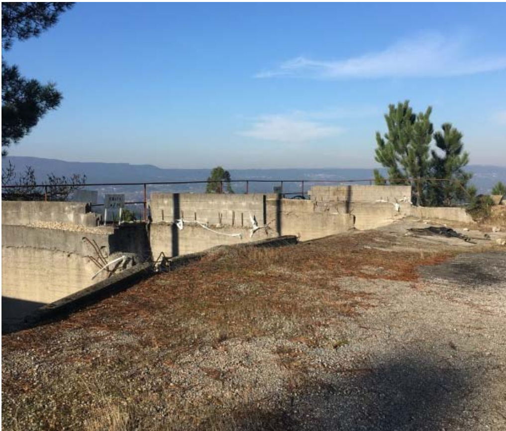
Imagen 23. Cubetos de recepción de materiales de la antigua cantera
