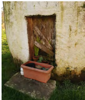
Exterior. Pormenor da porta de acceso
