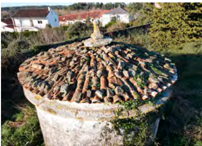
Fotografía aérea da cuberta
