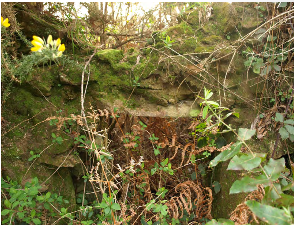
Exterior. Pormenor da porta de acceso
