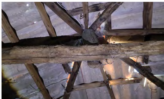
Interior, pormenor da estrutura da cuberta
