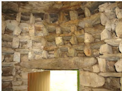
Interior. Nichos sobre a porta de acceso
