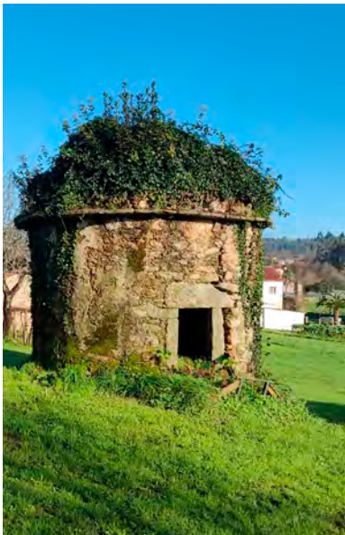
Exterior, porta de acceso
