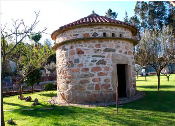
Exterior, porta de acceso
