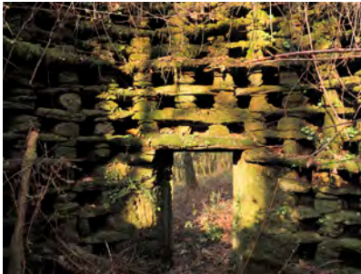
Interior. Nichos e porta de acceso
