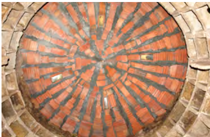
Interior. Pormenos da cuberta con ladrillo
