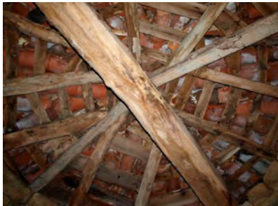
Interior. Pormenor da estrutura do teito
