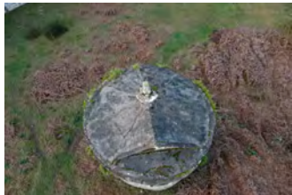
Fotografía aérea. Pormenor da cuberta
