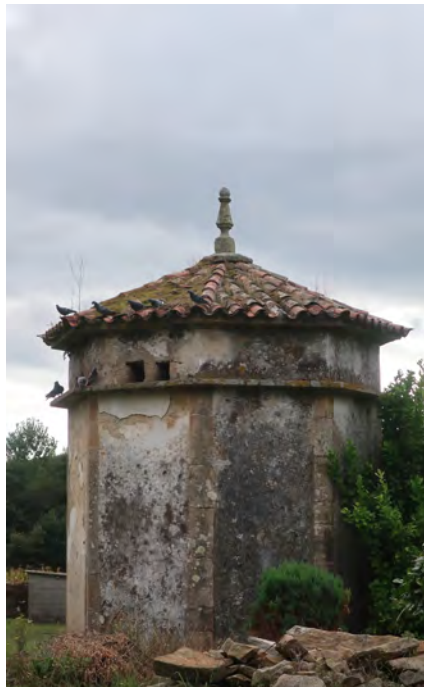
Exterior, porta de acceso
