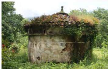
Exterior, lateral sur
