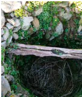
Fotografía aérea do interior (sen cuberta)
