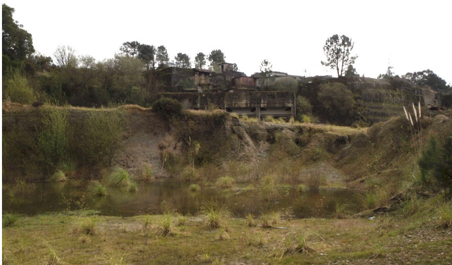
Imaxe 6. Vista da área de ubicación. Obsérvense os materiais heteroxéneos inestables e o gran desnivel.
