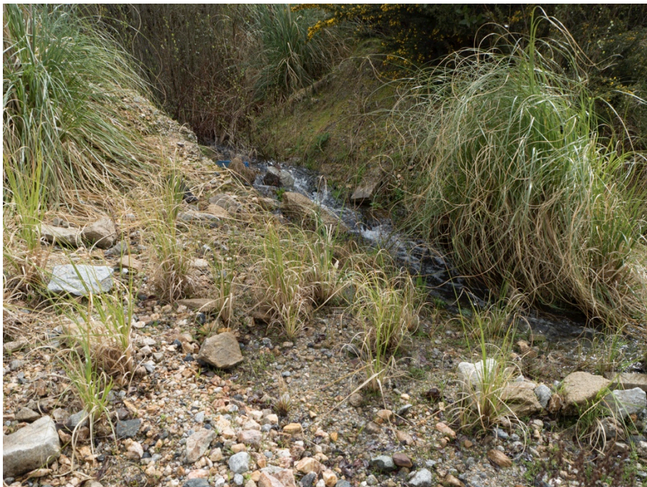
Imaxe 4. Vista en detealla de la zona de ubiación. Torrentes provocados por filtracións de augas, sobre material heteroxéneo e inestable. Igualmente poden apreciarse as especies exóticas invasoras.
