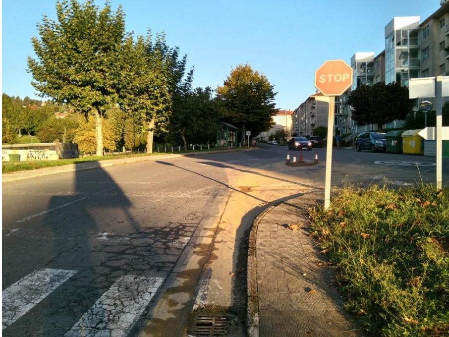
Fotografía 33. Rúa Bidueiro, sentido subida, en las proximidades de la intersección con rúa Carballo.
