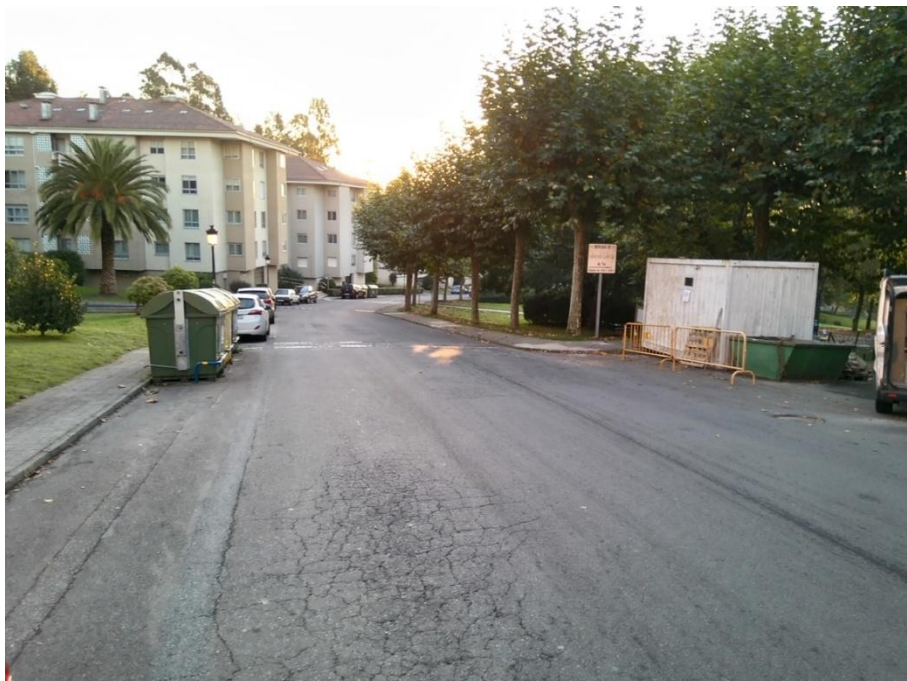
Fotografía 30. Rúa Carballo, sentido bajada. Tramo entre rúa Castiñeiro y rúa Carballo, 15.
