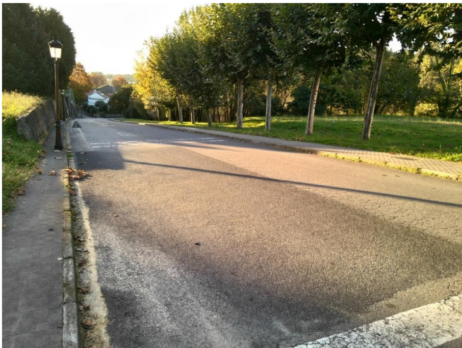
Fotografía 34. Rúa Bidueiro, sentido bajada, en las proximidades de la intersección con rúa Carballo.
