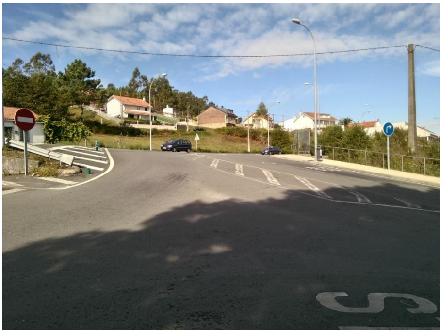
Fotografía 26. Rúa Carballo. Tramo entre la carretera AC-841 y la rúa Ameneiro.
